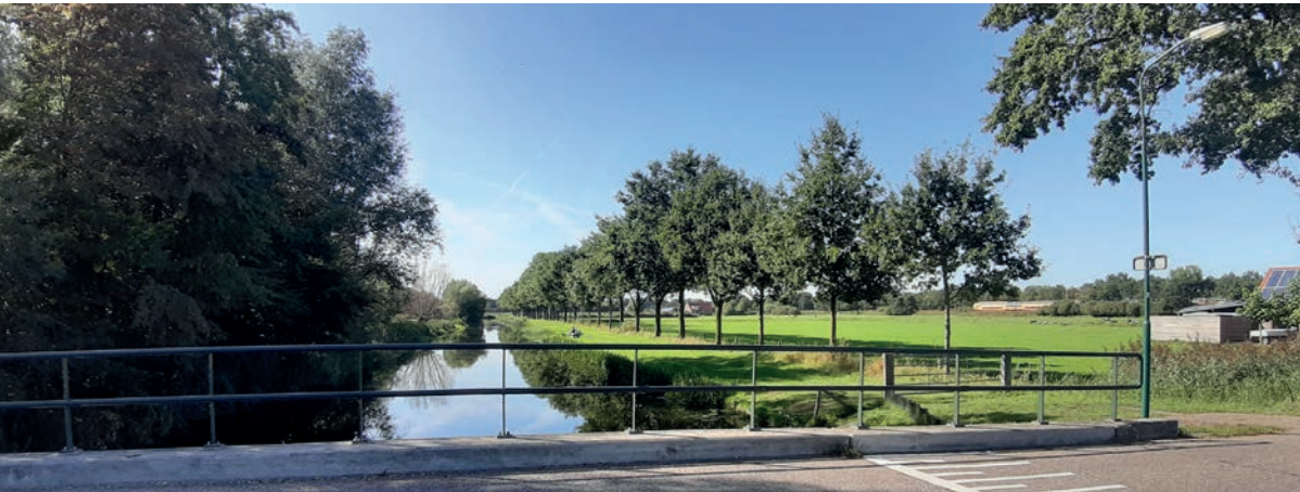
fig. 50 Valleikanaal, Heuvelsesteeg in Overberg. De kanaalzone wordt door beplanting afgeschermd van de A12.
